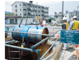
今宿(横浜1丁目外)地区下水道築造工事
