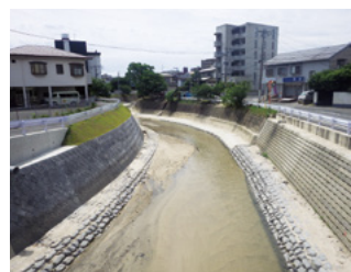
樋井川河床掘削工事1工区
