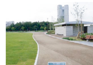
アイランドシティ地区(1工区)グリーンベルト整備工事
