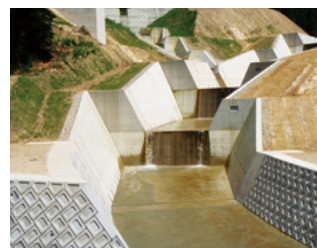
付替砂防流路工工事
