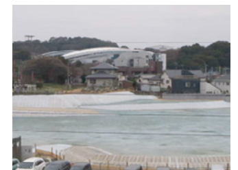
東平尾1丁目地内ふっ素土壌除去工事
