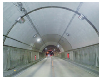
立花トンネル補修補強2期工事
