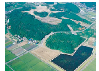
九州大学統合移転事業 用地造成工事
