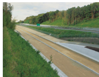
今宿道路糸島東地区改良工事
